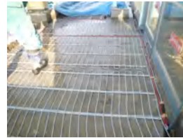
有ハウス作業棟新築工事ホ-チ床口-ドホテイング
