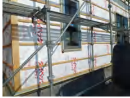
外壁工事 下地金物
