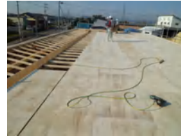
侑ハウス作業木工事 野地構 造用合板張り026
