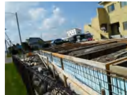
有ハウス作業棟新築工事059
