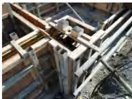
有ハウス作業棟新築工事067
