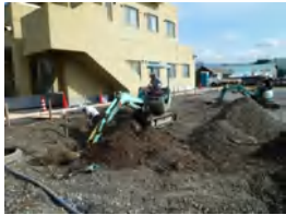
調査掘削状況
