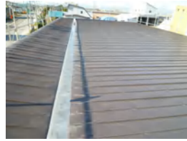
屋根がルバリウム鋼板フラット工法
