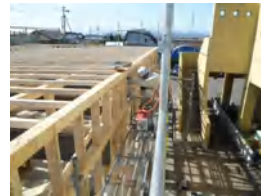
有ハウス作業鋼製建具工事小屋裏換気取り付け025
