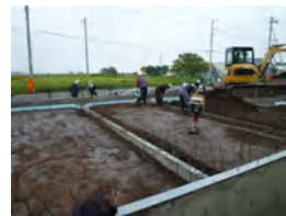
有ハウス作業棟新築工事094
