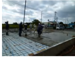
侑ハウス作業棟新築工事 120
