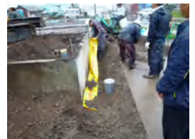
有ハウス作業棟新築工事095
