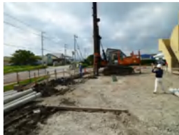
有ハウス作業棟新築工事021
