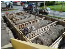
有ハウス作業棟新築工事072
