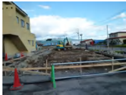
有ハウス作業 土工事根掘
