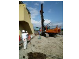
有ハウス作業棟新築工事027
