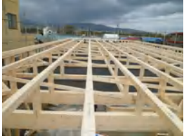
侑ハウス作業木工事小屋組 017
