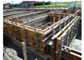
有ハウス作業棟新築工事066
