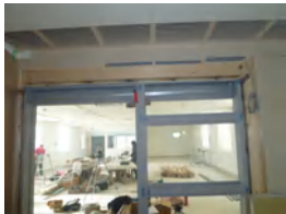
有ハウス作業棟新築工事鋼製建具枠ア-ク溶接取付
