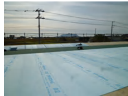
有ハウス作業屋根工事断熱ル-フ031
