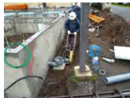
有ハウス作業棟新築工事090
