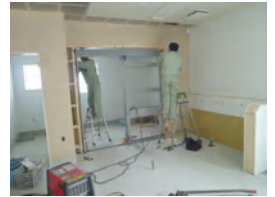
有ハウス作業棟新築工事 内部鋼製サッシ取付
