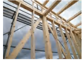
侑ハウス作業木工事軸組筋 違い金物 011
