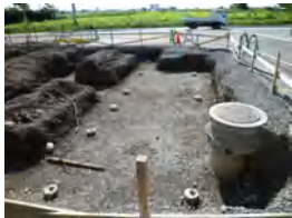
有ハウス作業棟杭頭処理
