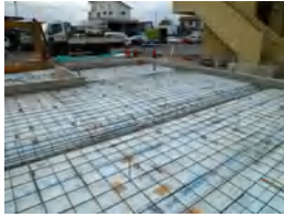
侑ハウス作業棟新築工事 110
