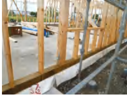
侑ハウス作業木工事柱ホル タウン022
